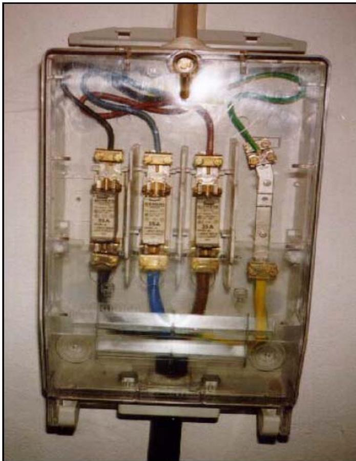
Abbildung 2.5 Hausanschlusskasten [15]
